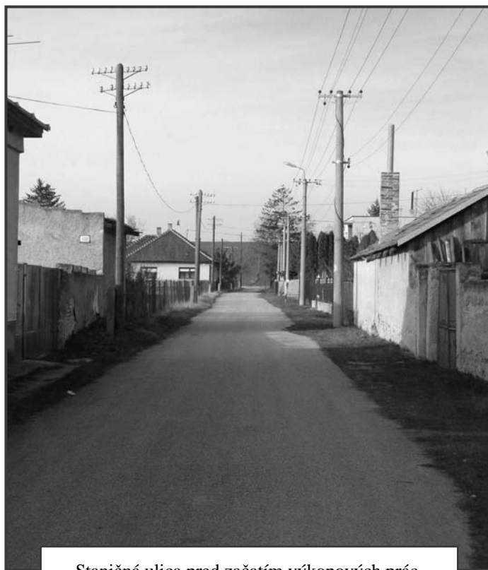
Staničná ulica pred začatím výkopových prác.
